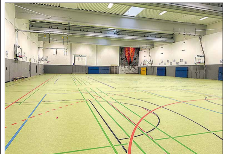
Erstrahlt in neuem Glanz: die frisch sanierte Sporthalle am Geschwister-Scholl-Gymnasium in Daun. Foto: Kreisverwaltung Vulkaneifel
