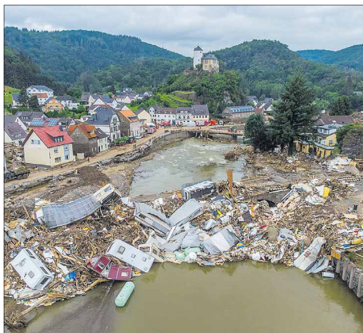
Meterhoch türmen sich im Juli 2021 wenige Tage nach der Flutkatastrophe Wohnwagen, Gastanks, Bäume und Schrott an einer Brücke über die Ahr in Altenahr-Kreuzberg. Foto: Boris Roessler/dpa
